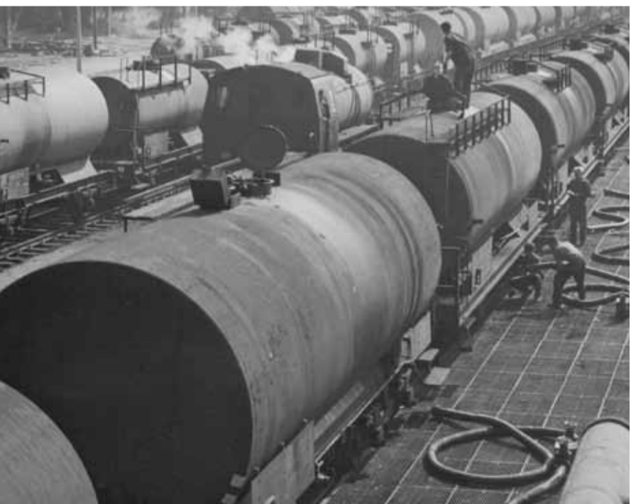
Die Kesselwagenverladung war eine Herausforderung für die Kollegen an den Befüllstationen und in der Logistik.
